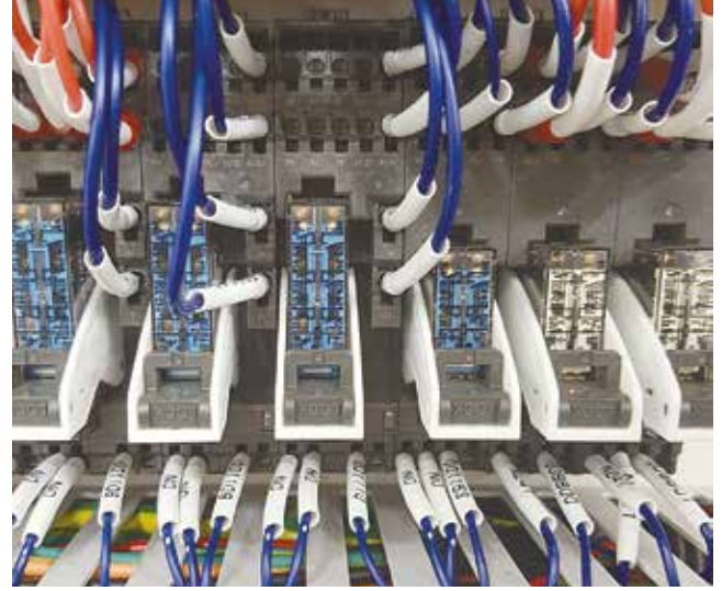
Komponentlerin %80'inde Push-In Plus terminaller bulunur.
