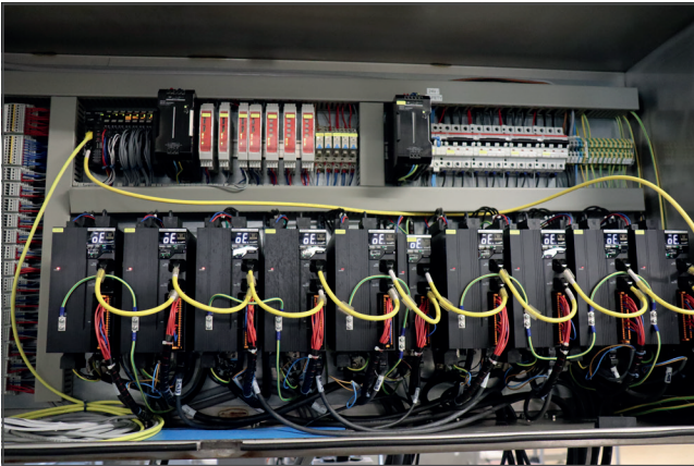
Donanım iyileştirme çözümünün temelinde, NX/NJ makine kontrolöründen yazılıma sürekli entegrasyon sağlayan OMRON'un 1S sürücülerine ek olarak Sysmac otomasyon platformu yer alır.
