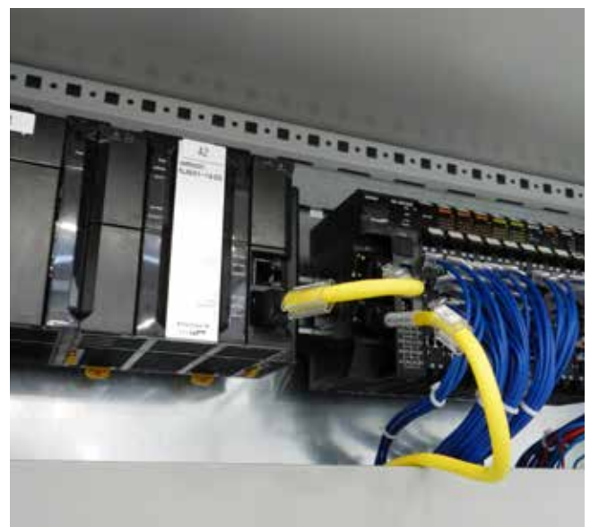
Sterownik maszyny Sysmac NJ501-1400 firmy Omron umożliwia bardziej elastyczną produkcję.
