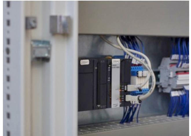
CPU di controllo Macchina Sysmac NJ
