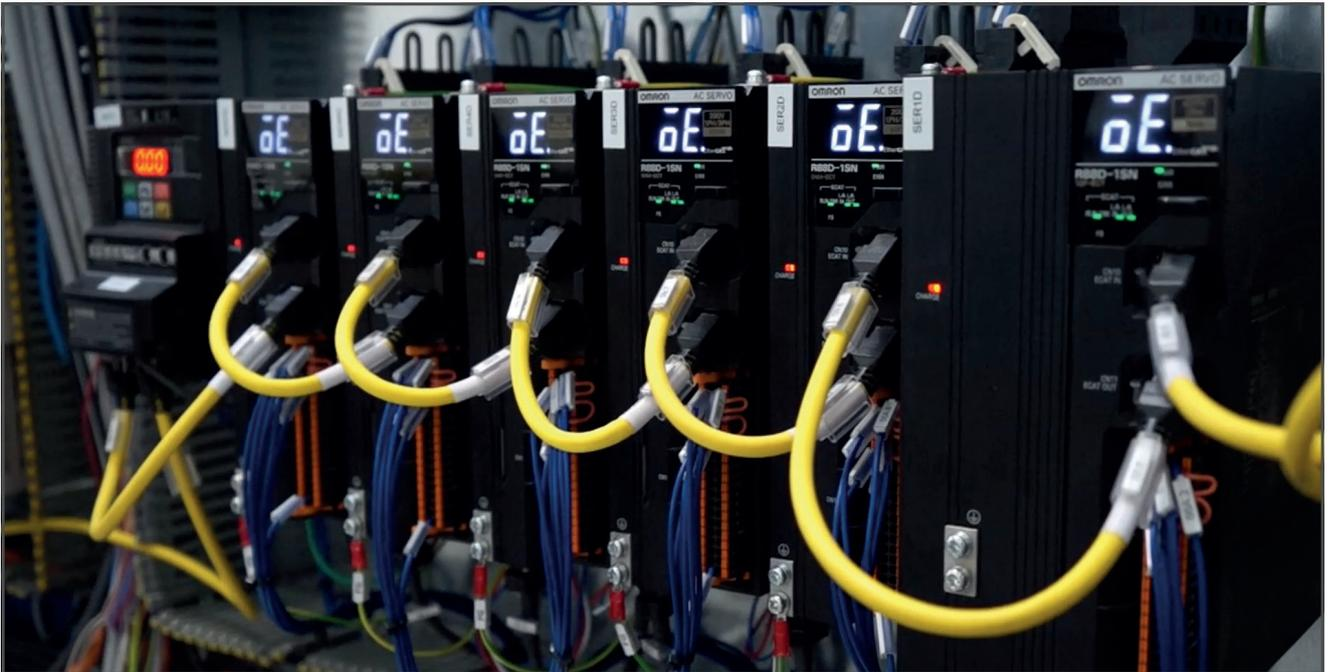
*Il controllore NX701 1600 gestisce 34 servosistemi OMRON 1S e 6 inverter 3G3MX2.*
