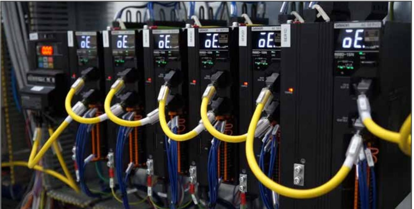
*Le contrôleur OMRON gère 34 servomoteurs OMRON 1S et six variateurs 3G3MX2.*
