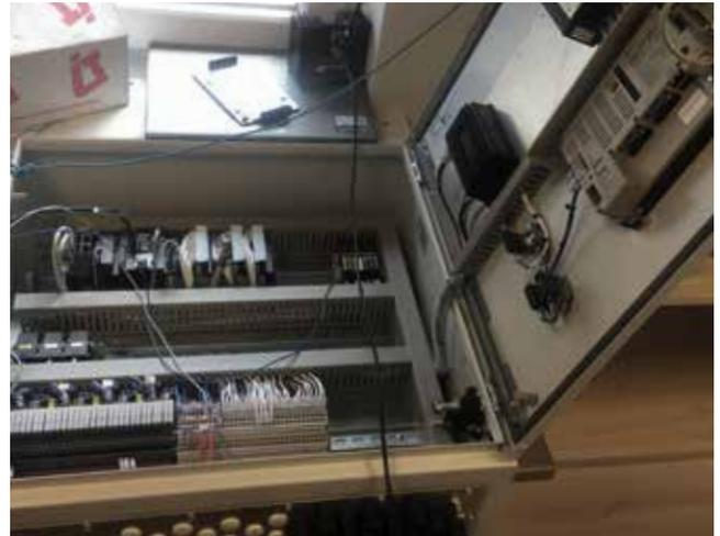
*Die neuen, kompakteren Value Design-Komponenten von Omron können aufgrund ihres geringeren Energieverbrauchs auch direkt nebeneinander montiert werden. Somit bleibt die Größe des Schaltschranks gleich, bietet jedoch zusätzlich Platz für die Sysmac-Plattform.*
