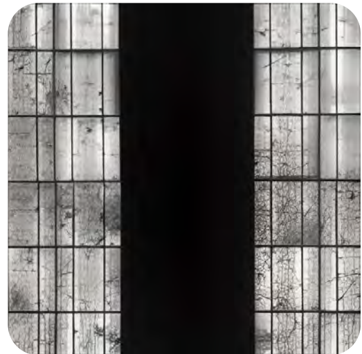
Esempio di pannello con diodo danneggiato.
