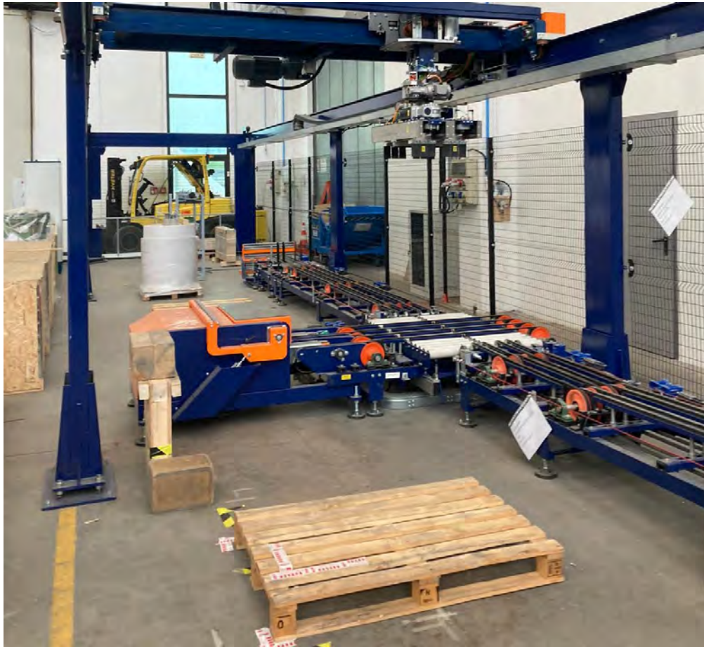
Figura 2.3.4: Impianto di pallettizzazione
