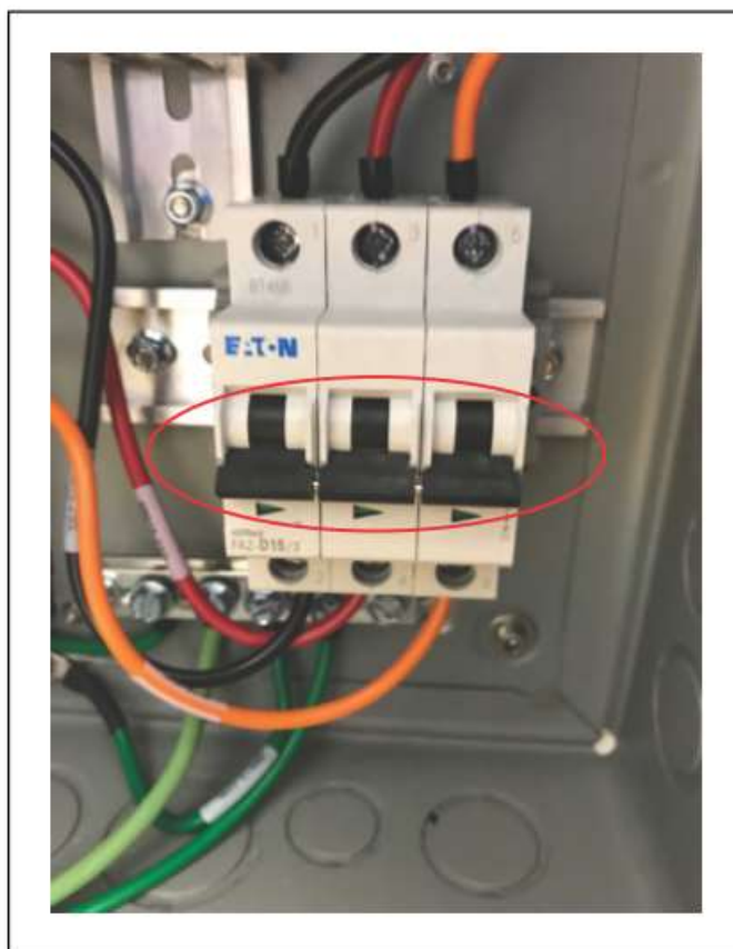
Ilustracja 2-24. Wyłączniki w zasilaczu – Pozycja ON
