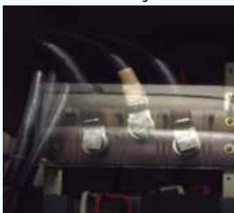
Een abnormale exotherme reactie van bedrading
