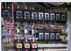
A berendezések túlmelegedése a panelen belüli hőmérséklet-emelkedés miatt
