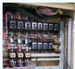
Egy panel eszközeinek rendellenes hőtermelése
