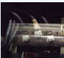
A vezetékezés rendellenes hőtermelése
