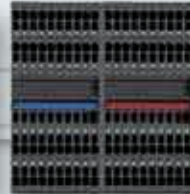
Bloques de terminales comunes
