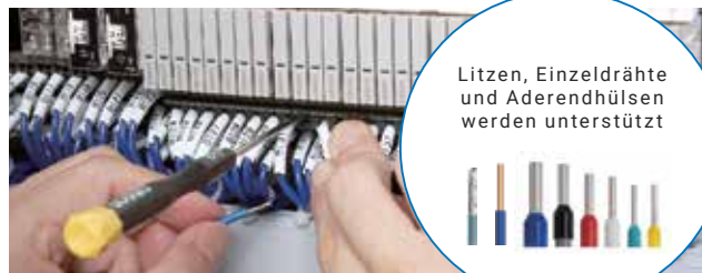
Value Design for Panel Verdrahten mit beiden Händen, weil der Schraubendreher in der Löseöffnung gehalten wird
