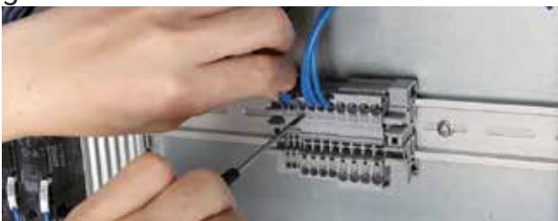
FRÜHER Einhändiges Verdrahten, die andere Hand hält den Schraubendreher
